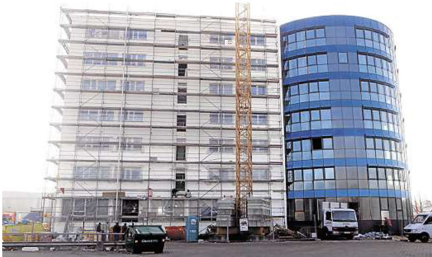
Das Ärztehaus „Vitanum“ in Bodenheim steht kurz vor der Fertigstellung.
