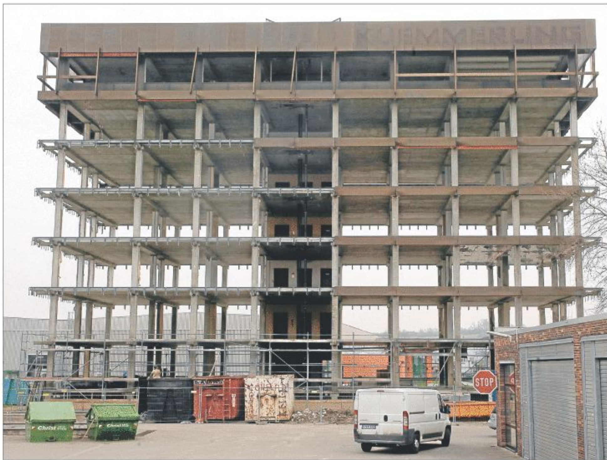
Völlig entkernt ist das Gebäude, in dem der Likörhersteller Kuemmerling früher seine Büros untergebracht hatte. ■ Foto: Braun
