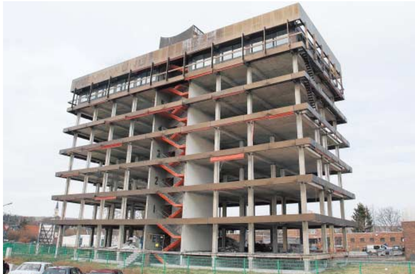
Das Kuemmerling-Hochhaus ist fast vollständig entkernt. In wenigen Wochen kann der Ausbau starten.
