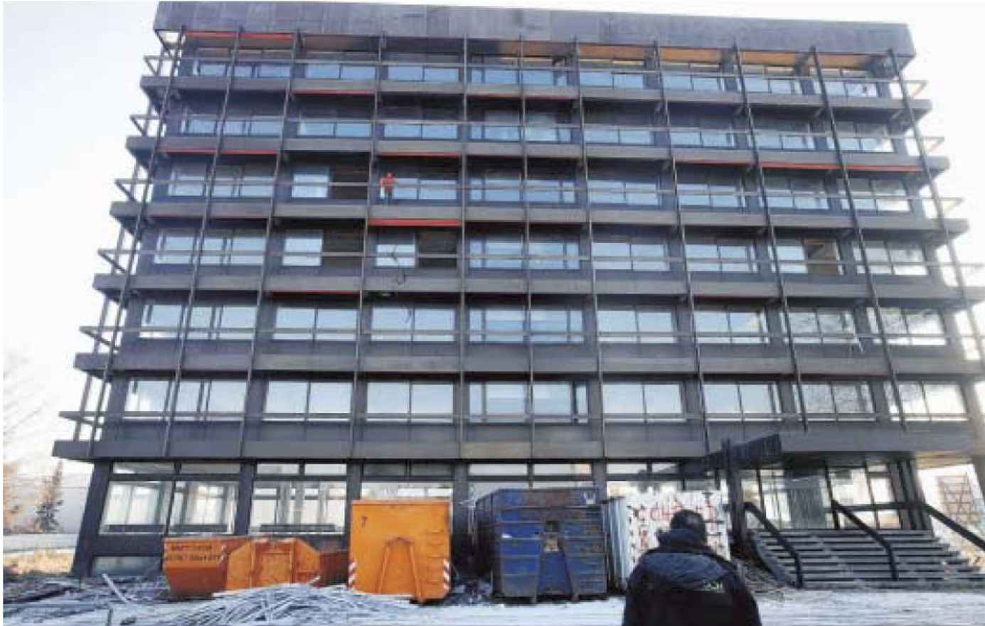
Das alte Kuemmerling-Verwaltungsgebäude in Bodenheim wird in ein Facharzt-Zentrum umgebaut.
